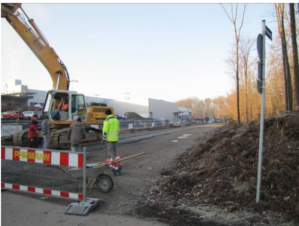
Die Baumaßnahmen der Straße sind bereits weit fortgeschritten!
